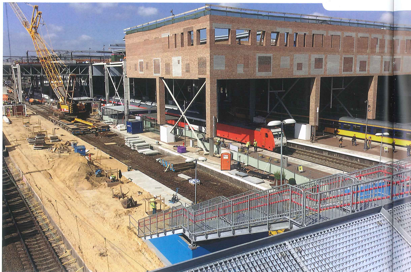
De nieuwe Openbaar Vervoer Terminal in Breda in aanbouw
